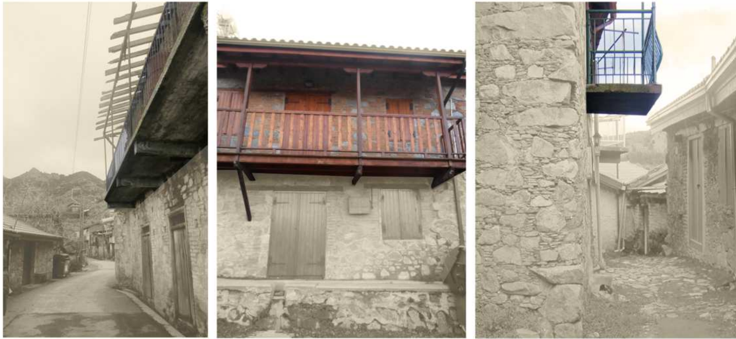
Εξώστες_Στηρίζονται στις προεκτάσεις "βολιτζιών" του κάτω ορόφου
